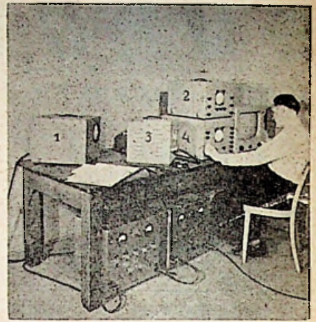
(Rechts) De zes eenheden van de lijnvertaler. 1. De weergeefbuis en de oscillator voor het laten trillen van de lichtstip; 2. de videoversterker en bedieningsorganen; 3. camera met beeldiconoscoop met versterkers; 4. tweede beeldsignaalversterker en bedieningsorganen; 5. en 6. Voedingsapparaten. Geheel rechts controleweergeefbuis
